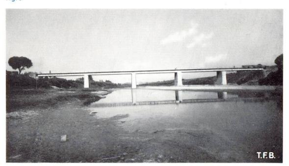
6 la légéreté du nouveau tablier montre bien que seule la précontrainte a permis une telle réalisation à lignes strictement horizontales, sans renforcements sur les piles. Au point de vue coût, cette forme offre aussi des avantages par rapport aux voûtes. On peut réaliser en béton précontraint des ponts de toutes formes.
