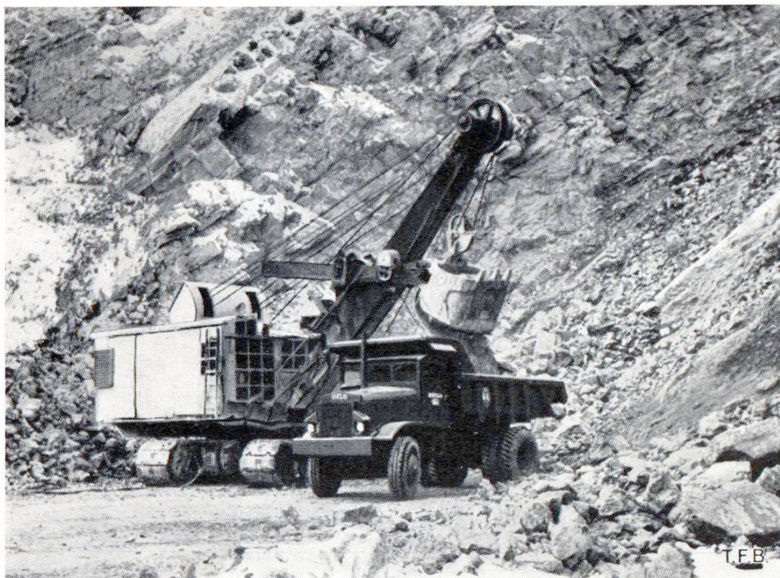
Fig. 7 Pelle mécanique électrique avec benne de 2 m 3 . Camion spécial de 15 t
