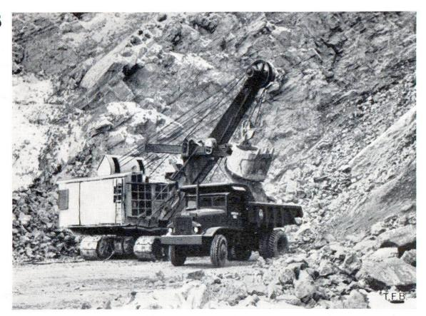
Fig. 7 Pelle mécanique électrique avec benne de 2 m<sup>3</sup>. Camion spécial de 15 t
