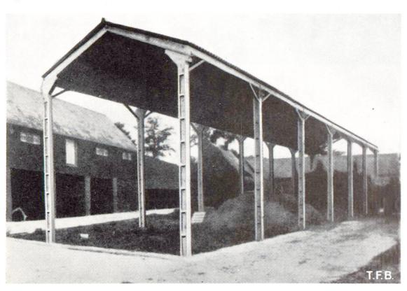
5 f) On entend dire parfois que les éléments préfabriqués en béton sont trop lourds pour un transport et un montage aisés. Ce n'est que rarement le cas. On peut limiter les dimensions et le poids de ces éléments aux possibilités des engins de levage normaux utilisés sur les chantiers, tels que petites grues, montecharges, mouffles, etc. Dans certains cas favorables, on peut même fabriquer les pièces principales à proximité immédiate du chantier, en supprimant ainsi les frais de transport.
