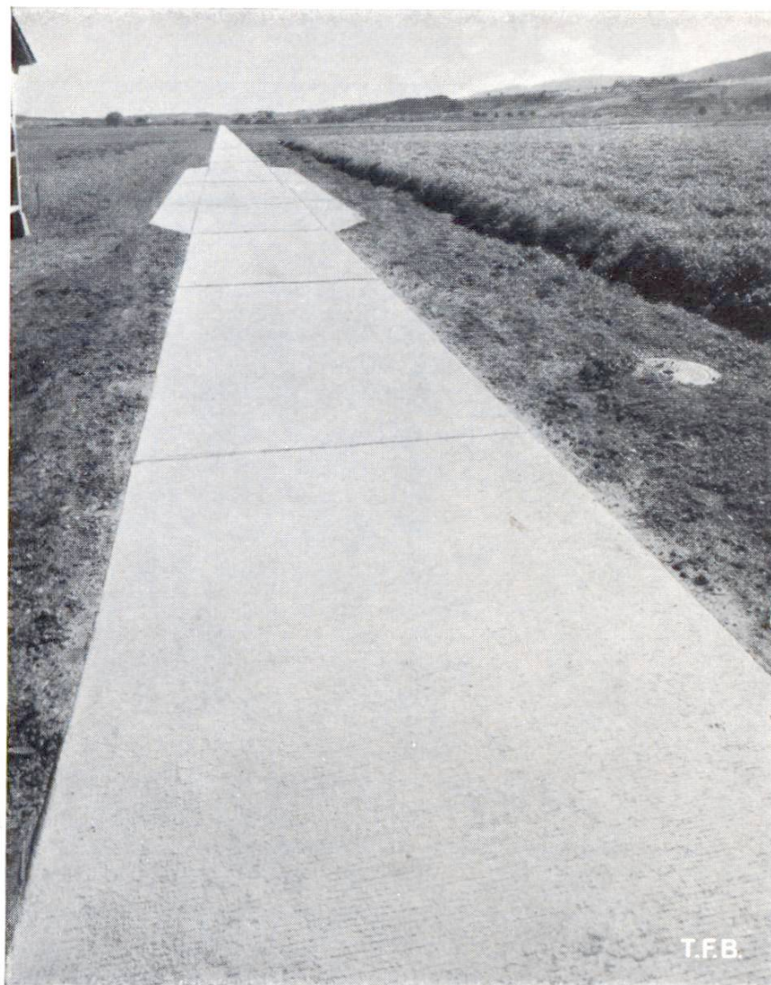
Fig. 21 Chemin d'améliorations foncières près d'Orbe VD, avec place de croisement. Largeur 2,80 m. Construction de 1951
