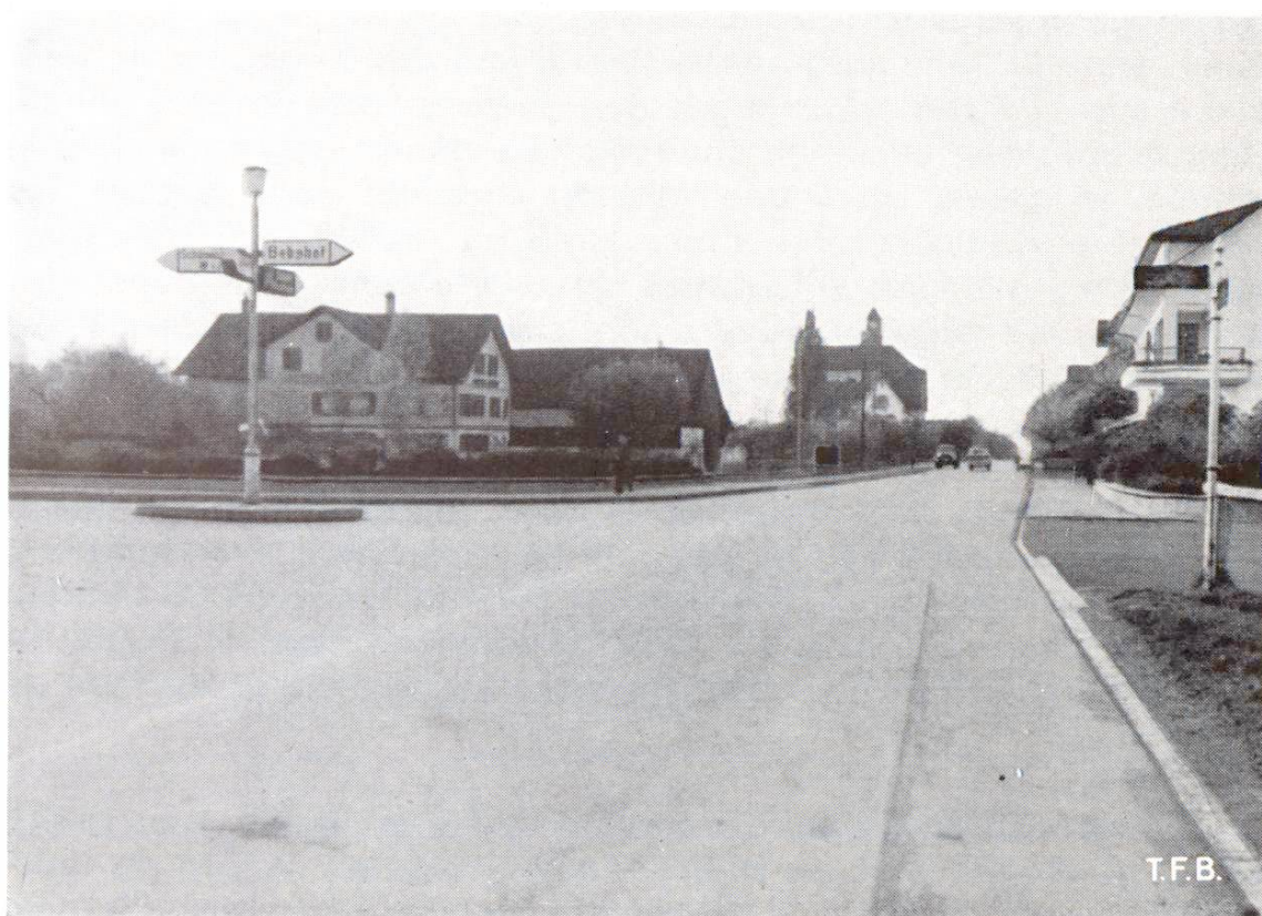
Fig. 12 La place du village de Kradolf. Revêtement de la chaussée construit en 1932, îlot central et trottoirs en 1950 et 1952
