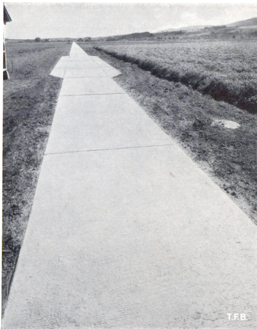
8 Fig. 21 Chemin d'améliorations foncières près d'Orbe VD, avec place de croisement. Largeur 2,80 m. Construction de 1951
