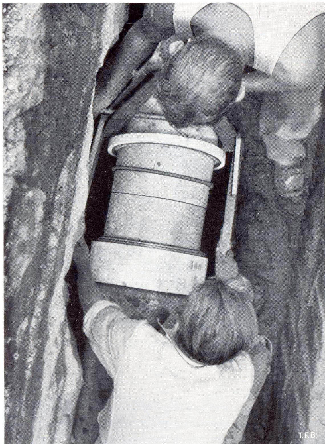
Fig. 7 Montage d'une conduite de 300 mm pour 18 atm.
