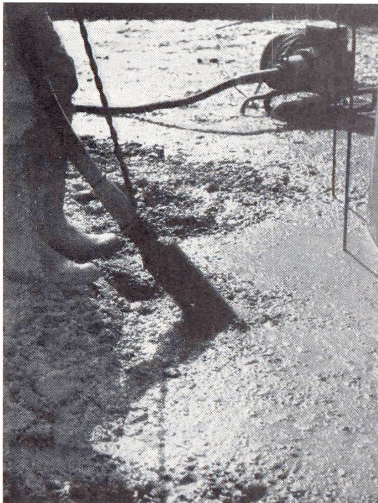
Fig. 5 Vibration à l'aide d'une aiguille, jusqu'à ce que l'eau et les bulles d'air apparaissent à la surface
