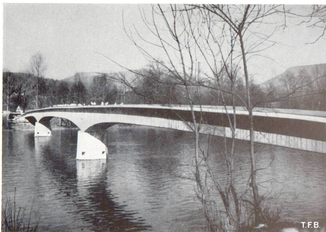
Fig. 15 Passerelle pour piétons sur l'Aar à Aarau. Longueur 110 m, portée de la travée centrale 41 m
