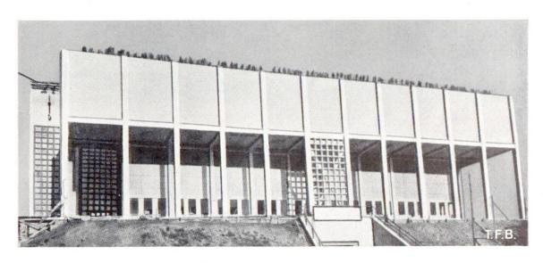
Fig. 6 Réservoir de 7000 m³ de la ville d'Orléans. Au bord supérieur, on remarque les extrémités des câbles verticaux du système Freyssinet
