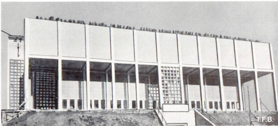
Fig. 6 Réservoir de 7000 m 3 de la ville d'Orléans. Au bord supérieur, on remarque les extrémités des câbles verticaux du système Freyssinet
