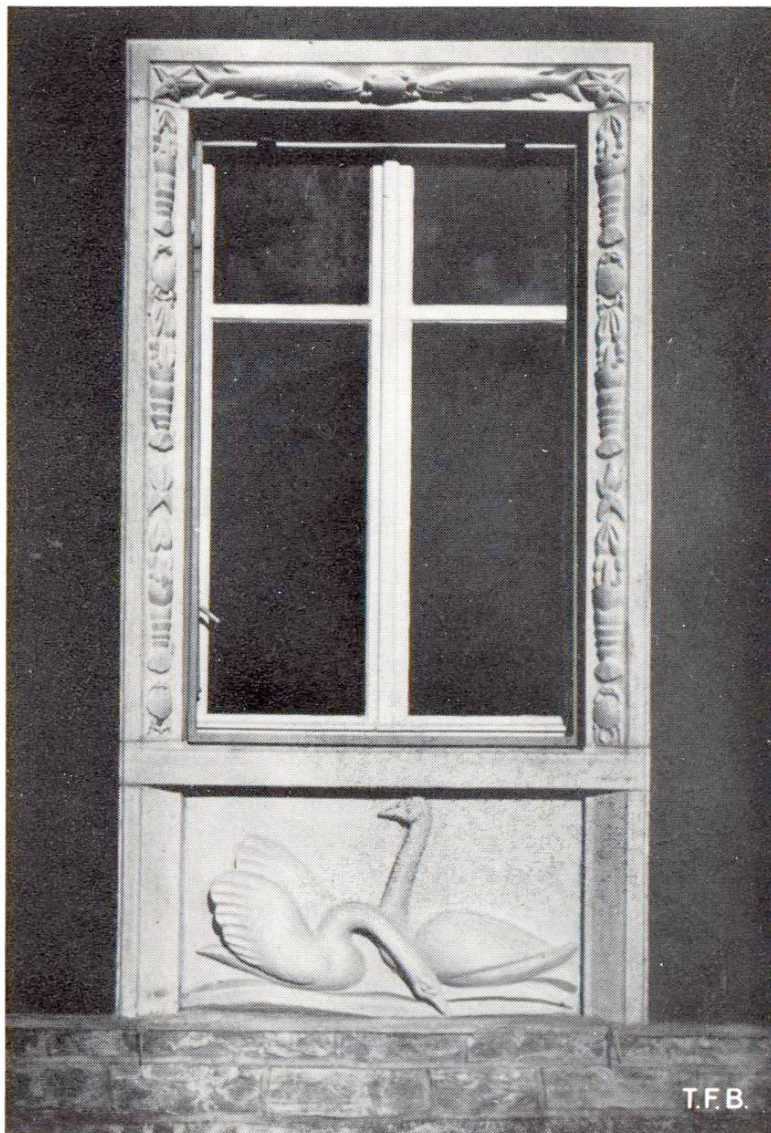
Fig. 4 Oeuvre en béton. Encadrement de fenêtre avec motifs en relief. Maison à Minusio. Sculpteur Max Uehlinger, Minusio
