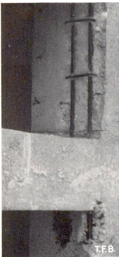
Fig. 2 Malgré une épaisseur suffisante de béton paraissant compact, les fers se sont rouillés et l'ont fait éclater. Un examen plus approfondi a montré que ce béton était perméable
