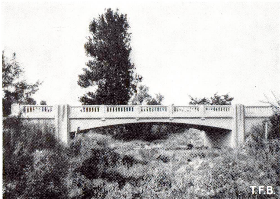
Fig. 8 Pont sur ruisseau en Amérique
