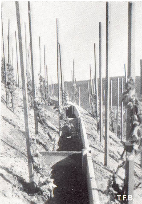
Fig. 3 Fossé en planches de béton avec traverses augmentant la possibilité de décantation
