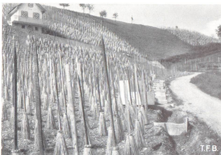
Fig. 5 Vigne avec fossé combiné muni de traverses en béton. On distingue aussi un bassin double en béton
