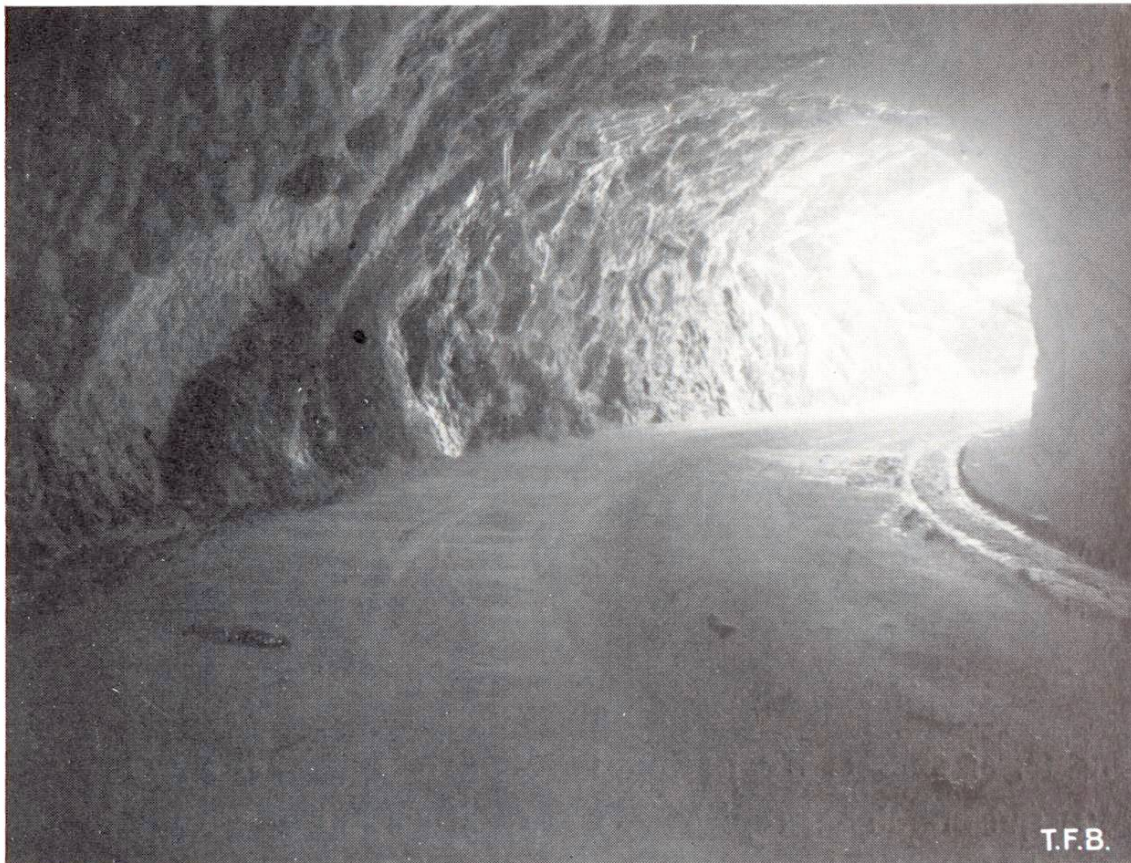
Fig. 4 Tunnel à parois rocheuses brutes. Violent contraste entre l'intérieur et l'extérieur, ombres portées
