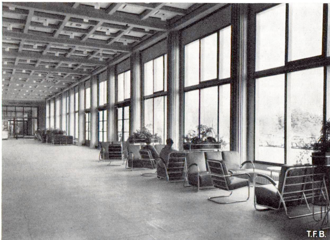
Fig. 2 Le grand promenoir de la partie centrale (66 m × 6 m) relie les deux services „Départ Etranger” et „Départ Suisse”. La lumière du jour y a un très large accès, tandis que l'éclairage artificiel du plafond crée une décoration des plus harmonieuse
