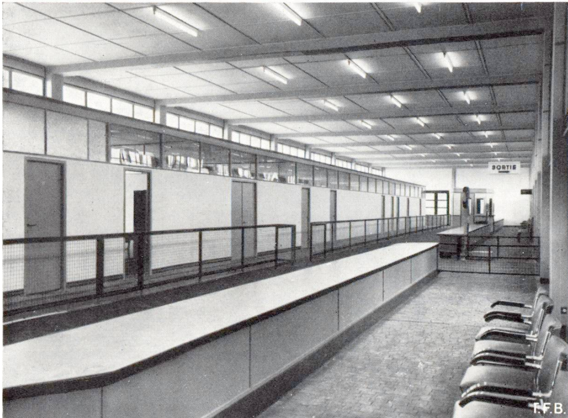
Fig. 7 Le hall pour les contrôles douaniers (66 m de long) est disposé le plus simplement possible: d'un côté le contrôle des arrivées, de l'autre celui des départs, les bagages avançant parallèlement aux voyageurs
