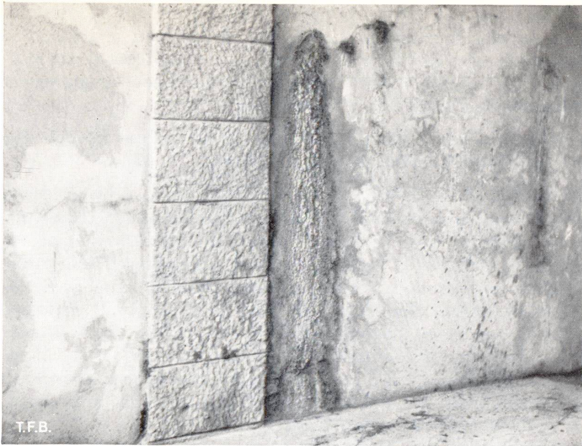
Fig. 5 Délèvement du ciment dans un appui de pont présentant des parties poreuses. Isolation insuffisante
