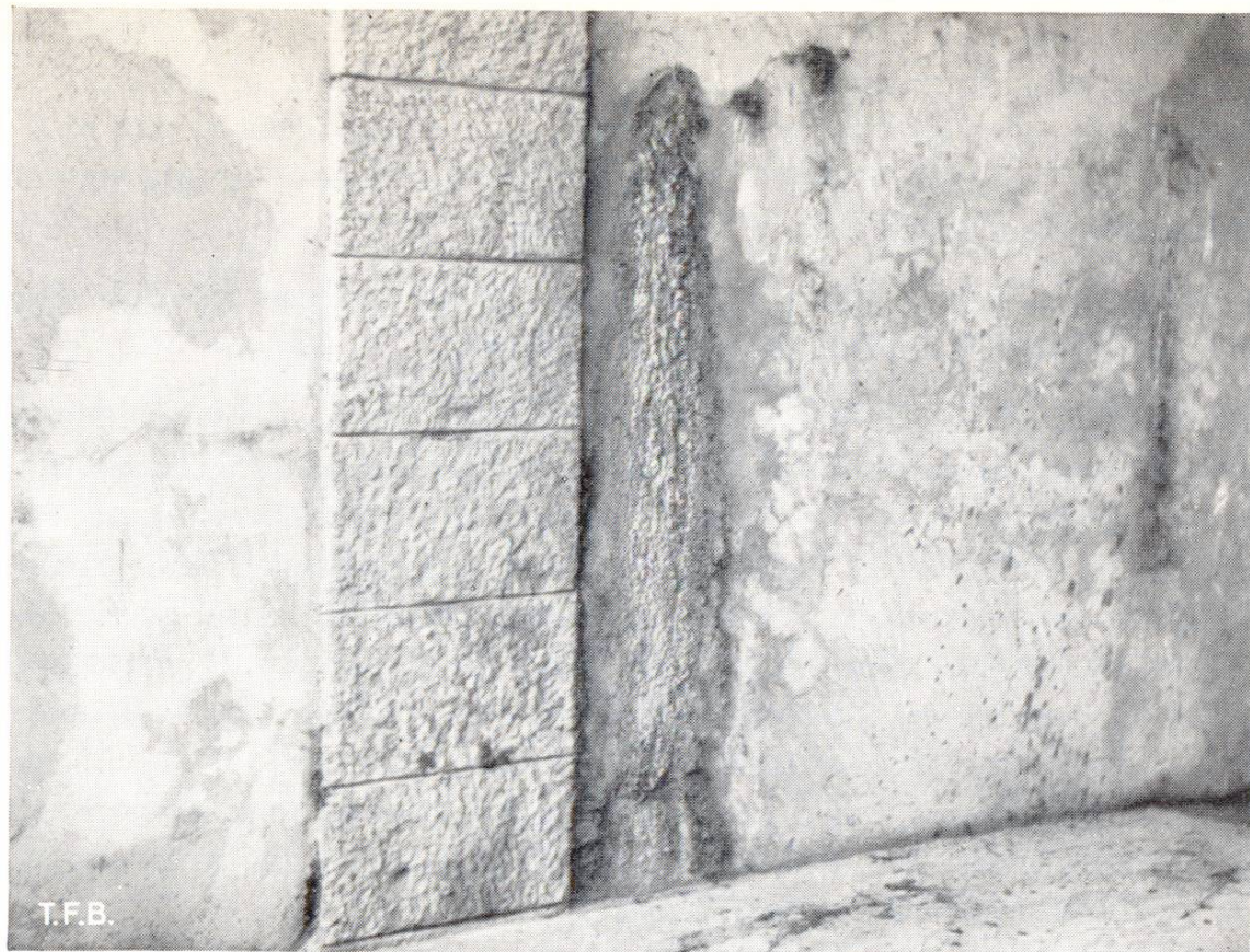
Fig. 5 Délavement du ciment dans un appui de pont présentant des parties poreuses. Isolation insuffisante
