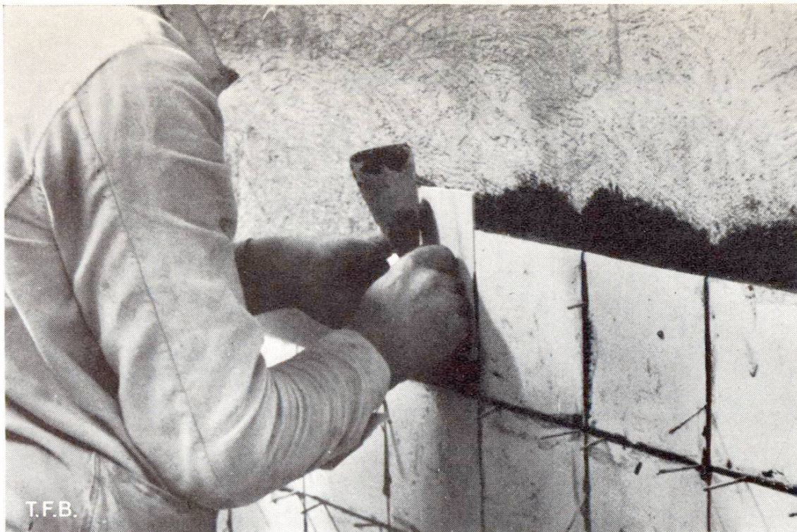
Fig. 5 Pose d'un revêtement suivant le procédé par collage
