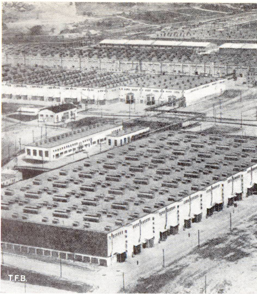
Fig. 6 Vue partielle du centre de production atomique Oak Ridge (USA)
