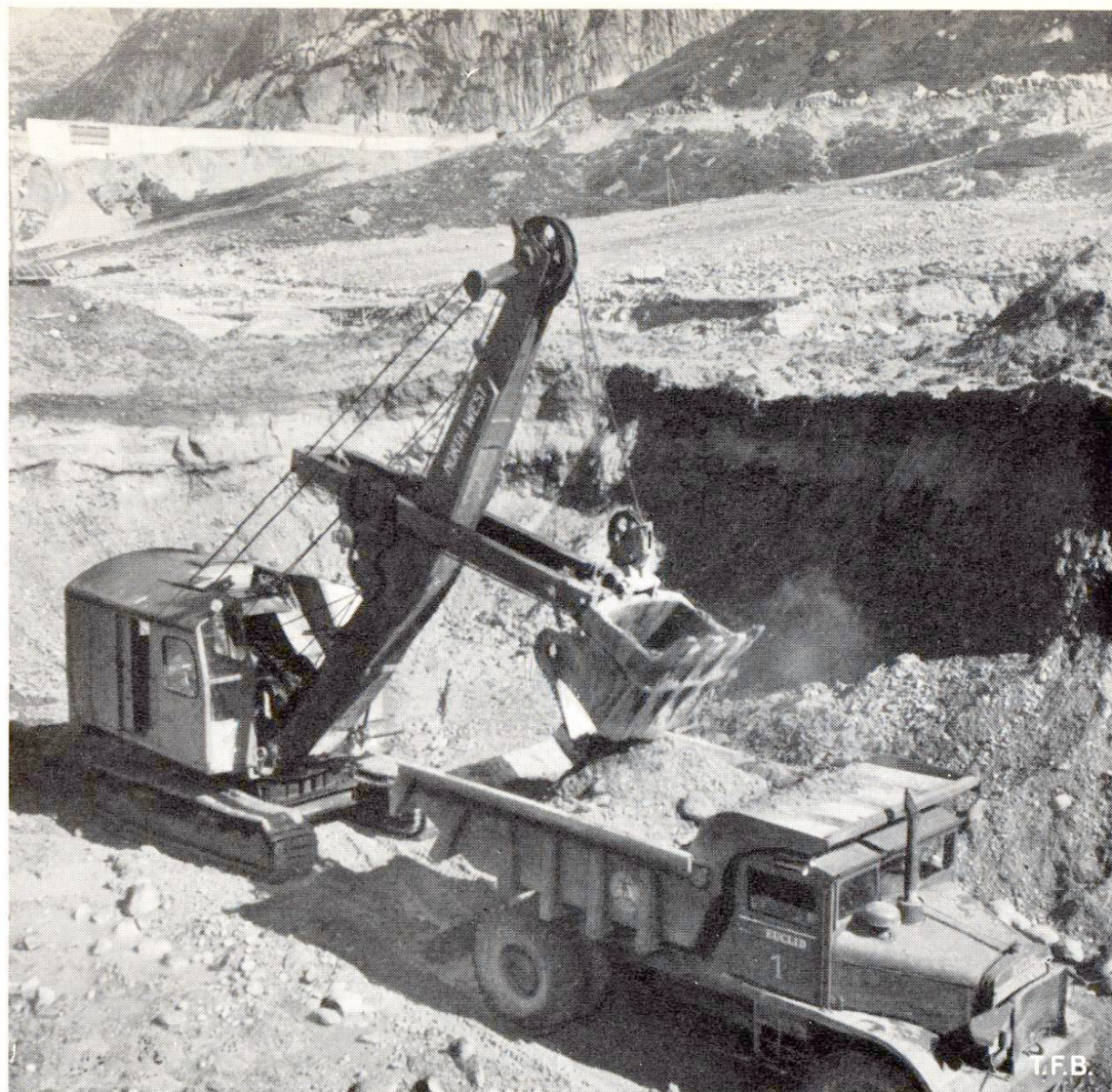
Fig. 1 Exploitation des graviers. Les gros camions Euclide de 8 m 3 transportent les matériaux atriage primaire qui élimine les pierres d'un diamètre supérieur à 18 cm
