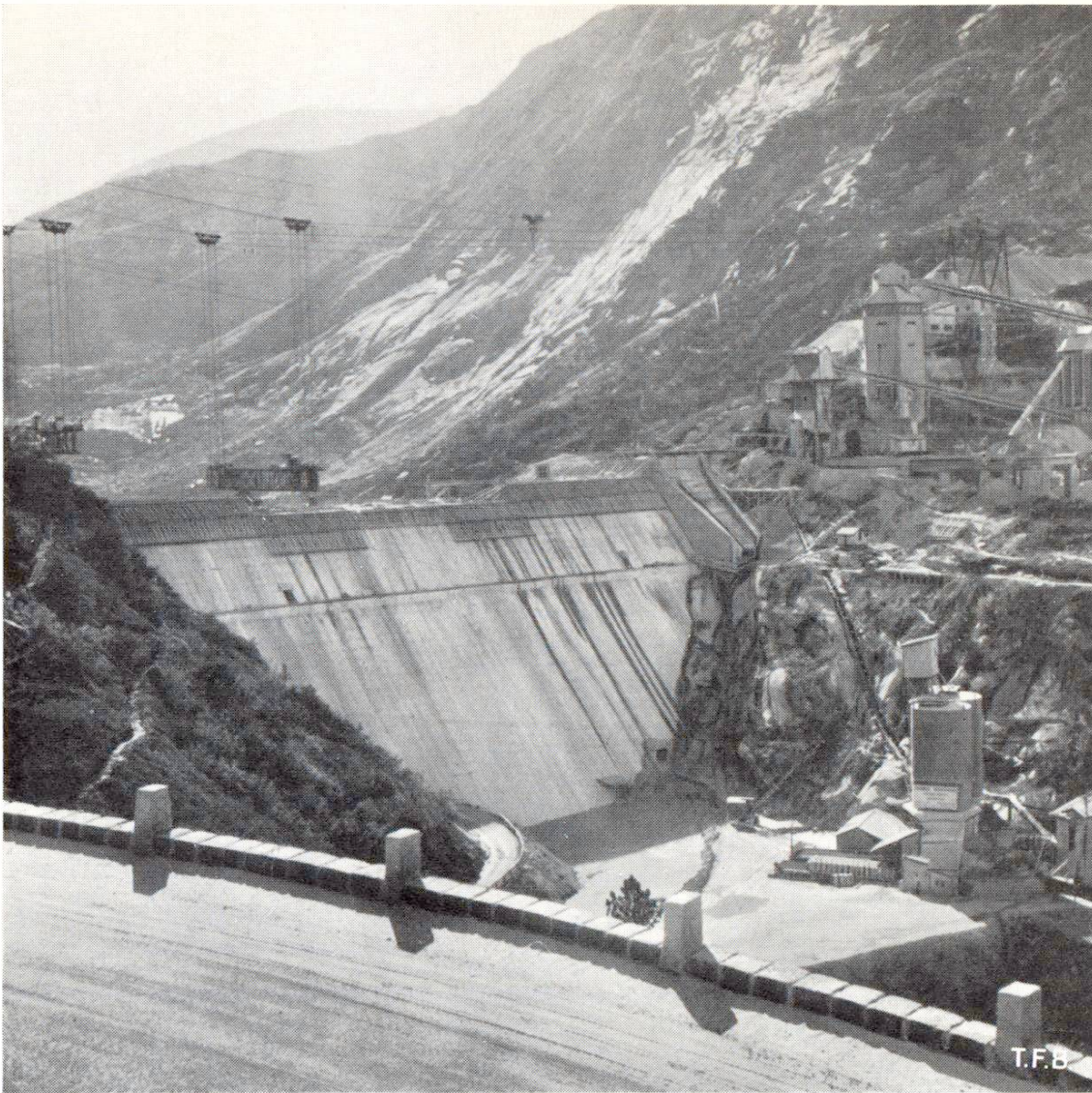
Fig. 5 Le barrage de Räterichsboden. A droite en bas, les silos à ciment de 2000 t de capacité totale. A droite en haut, l'usine à béton
