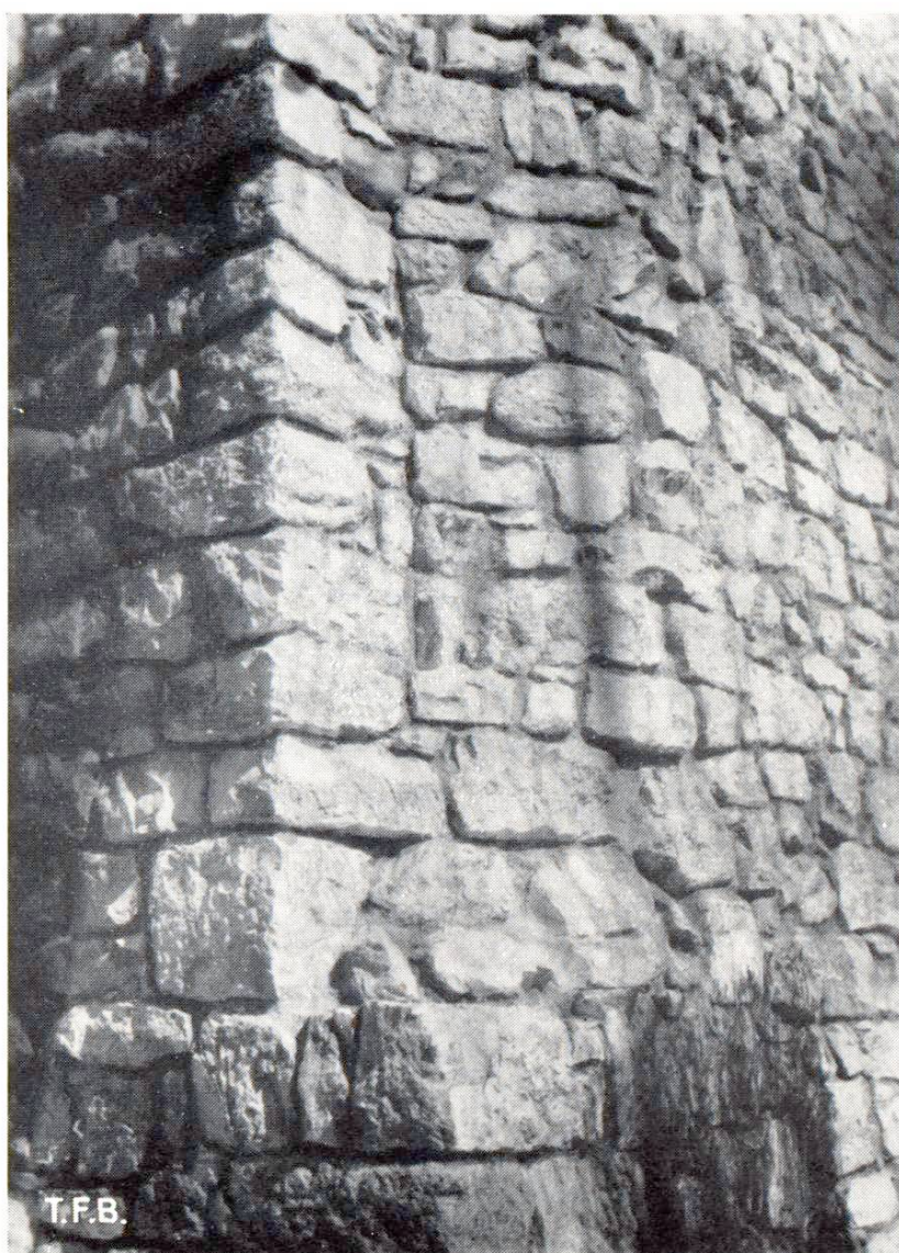
Fig. 2 Fortifications médiévales construites en chaux hydraulique
