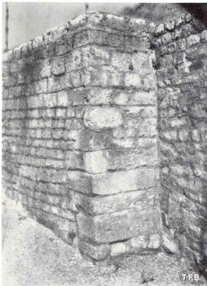
Fig. 1 Mur romain en chaux hydraulique (3 ans ap. J. C.)
