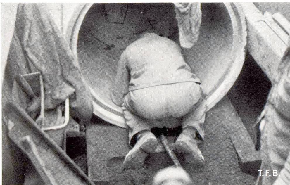
Fig. 7 Pose des tuyaux sur la semelle fraîchement bétonnée
