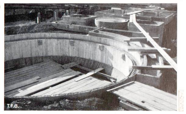
Fig. 6b Le bassin de décantation en construction. Derrière, l'agitateur et le doseur à chaux. Au fond les séparateurs d'huile
