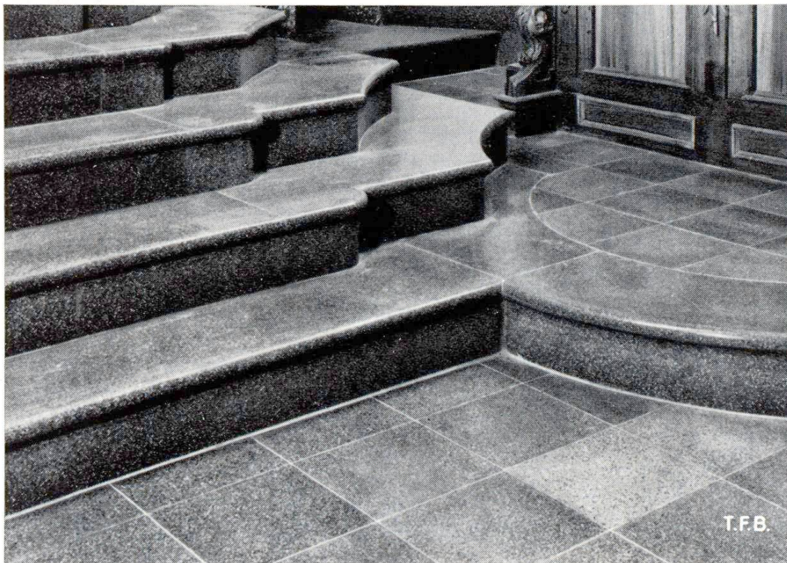
Fig. 6 Revêtement de sol et escalier en pierre artificielle
