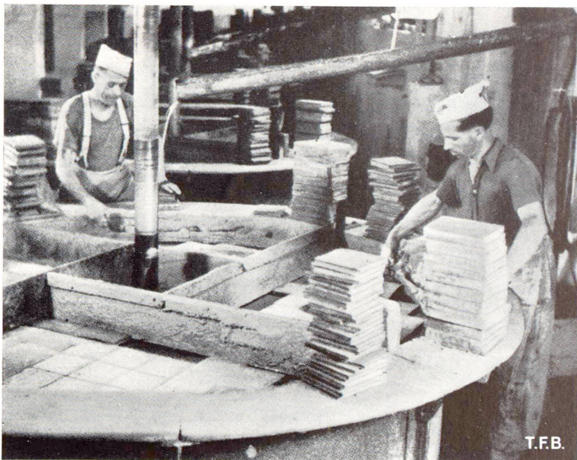
Fig. 4 Machine à égriser avec disque formant table, servant à la préparation de plaques pour revêtement de sols
