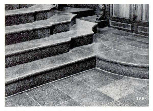
Fig. 6 Revêtement de sol et escalier en pierre artificielle
