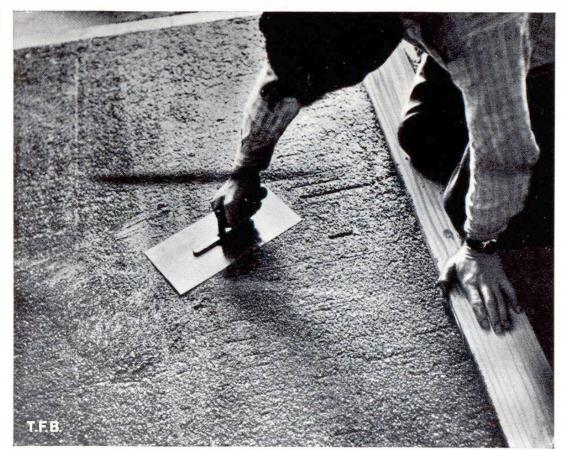
Fig. 4 Lissage de la chape au moyen d'une taloche spéciale
