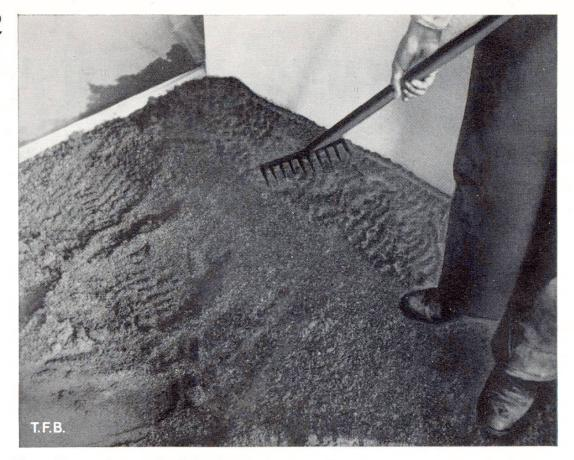
Fig. 1 Le mortier est égalisé sommairement au râteau
