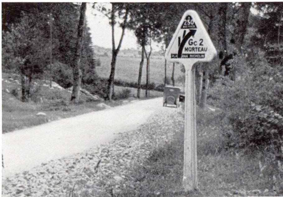
Fig. 4 Le premier indicateur avancé du monde, placé par Michelin en 1930. Il est entièrement en béton
