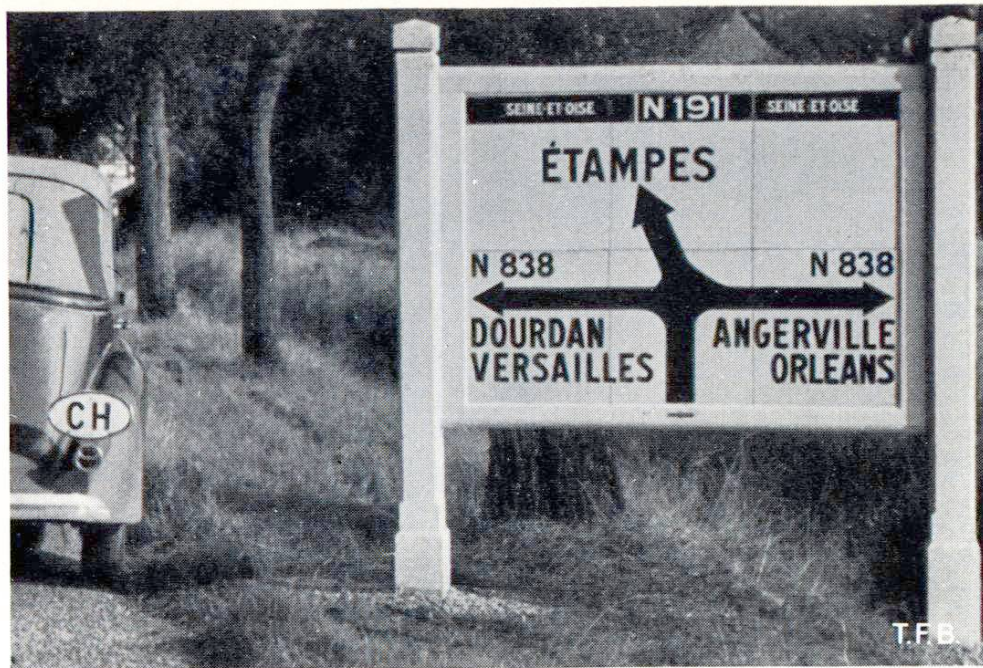
Fig. 5 — Combinaison lave-béton, premièrement en France
