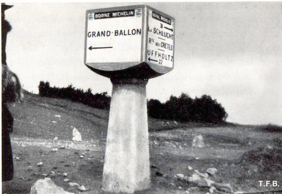
Fig. 3 Le premier poteau indicateur en béton placé en France vers la fin de la première guerre mondiale
