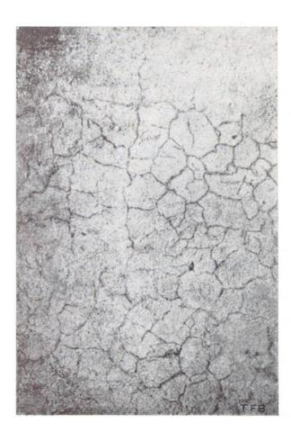
Fig. 2 Fissures de retrait sur un enduit préparé avec un excès de sable fin et qui, en outre, s'est desséché prématurément
