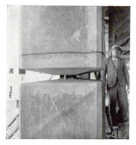
Fig. 9 Introduction d'une articulation dans un pilier existant. A gauche, aménagement du logement de l'articulation; à droite, articulation achevée (SBZ No. 9 1948)
