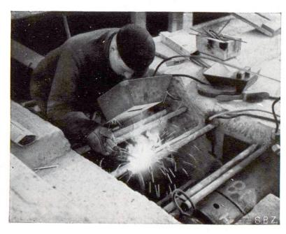
Fig. 4 Articulation de montage à la clef du pont de Lorraine des CFF à Berne (Portée 150 m). Soudage des fers ronds après le soulèvement par compression de la grande voûte. On voit un vérin hydraulique bloqué sous les armatures. (SBZ tome 116)
