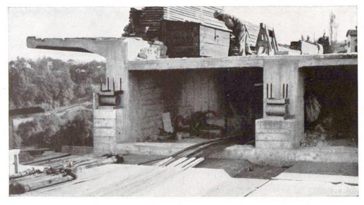
Fig. 7 Appui à rouleaux d'une poutre intermédiaire. Pont du Fürstenland près de St. Gall (SBZ tome 118)
