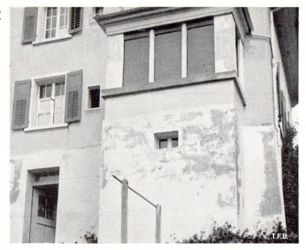
Fig. 1 Ecaillement d'une peinture à la chaux sur une fondation en béton et sur des enduits exposés
