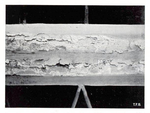
Fla. 6 Décomposition et écaillement d'une peinture spéciale sur une nervure en béton
