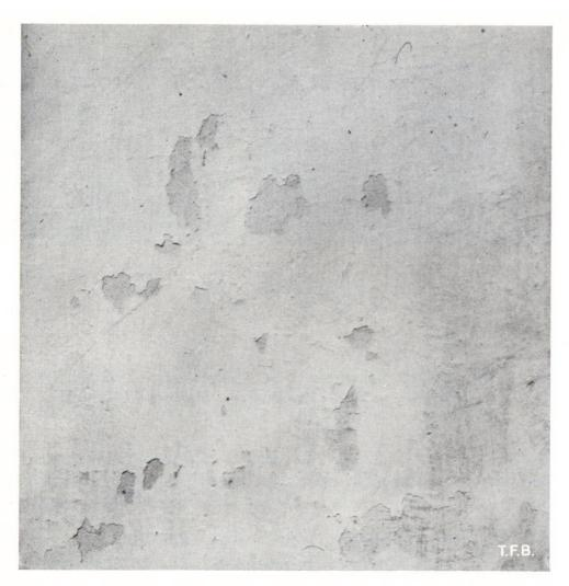
Fig. 3 Ecaillement d'une peinture de façade dû à une adjonction inappropriée au mortier
