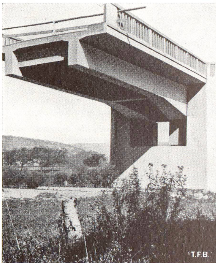
Fig. 6 Pont de St. G ry sur le Lot (France). Porte   faux de 14 m rive gauche, montrant la section du pont, l'augmentation de hauteur et l' largissement des poutres ma tresses au-dessus de l'appui
