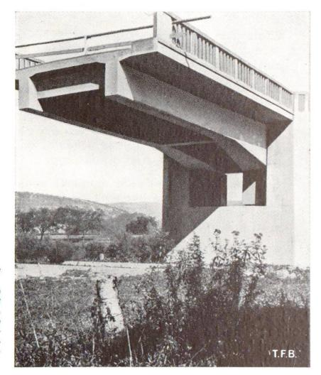
Fig. 6 Pont de St. Géry sur le Lot (France). Porte à faux de 14 m rive gauche, montrant la section du pont, l'augmentation de hauteur et l'élargissement des poutres maîtresses au-dessus de l'appui
