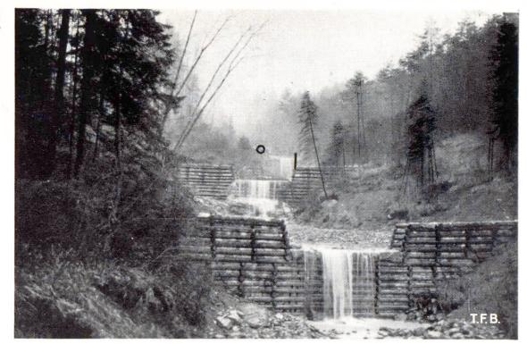
Fig. 1 Barrages en bois remplis de pierres sur le Widenbach, Altstätten
