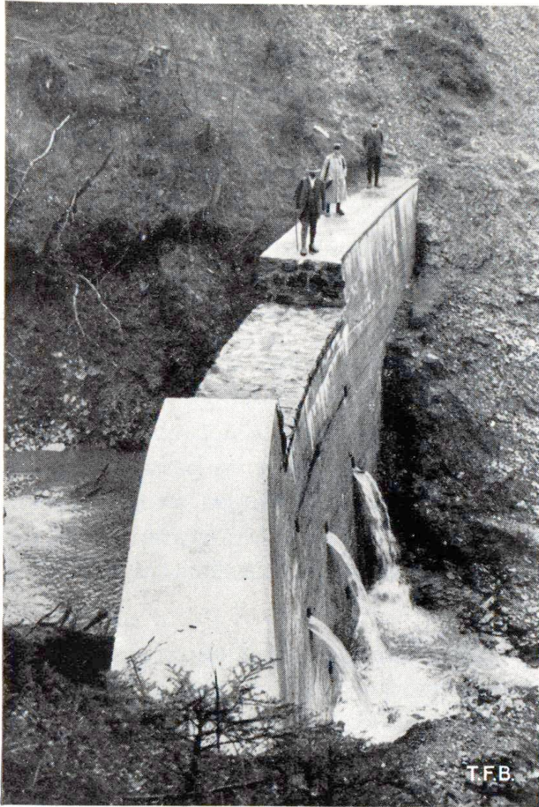
Fig. 5 Barrage en béton à déversoir revêtu de pierres naturelles, peu après l'achèvement de la construction. Aujourd'hui rempli de matériaux de charriage à l'amont. Trübbach près de Trübbach, canton de St. Gall
