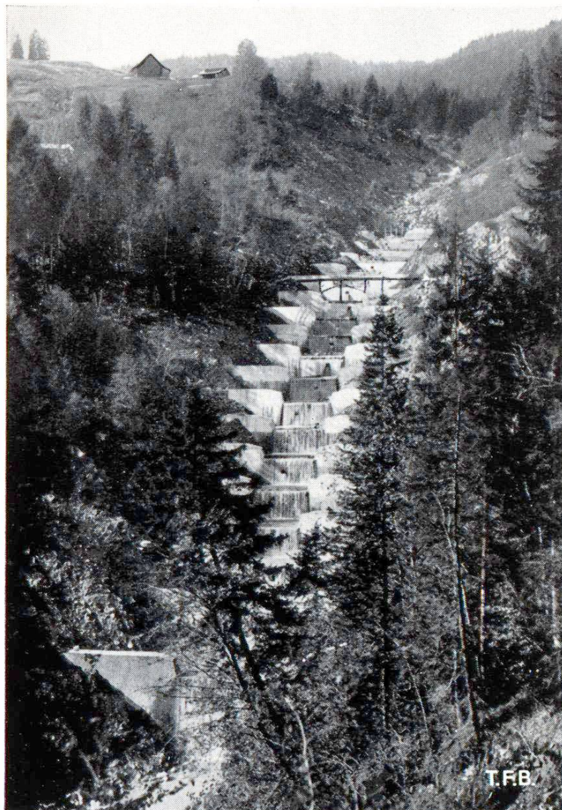
Fig. 6 Escalier de barrages en béton à déversoirs revêtus de pierres naturelles. Mettenlauri à Giswil, Obwald. Vue prise en 1934. Aujourd'hui les berges du torrent sont entièrement recouvertes de buissons et de jeunes arbres.
