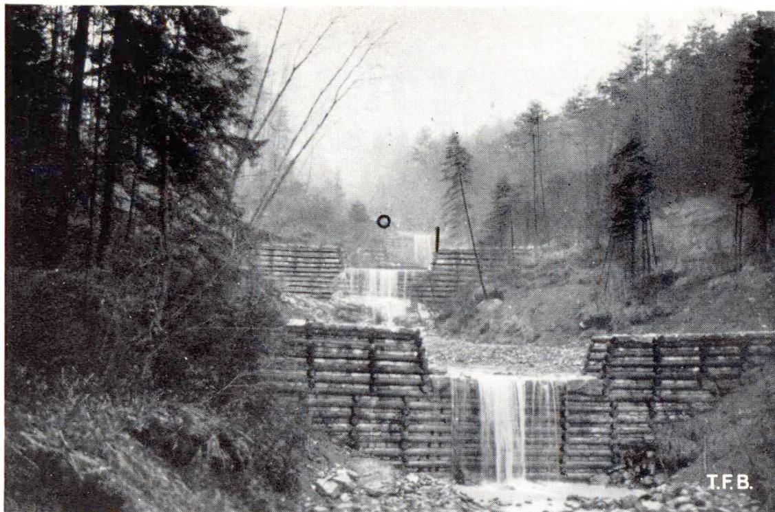
Fig. 1 Barrages en bois remplis de pierres sur le Widenbach, Altstätten
