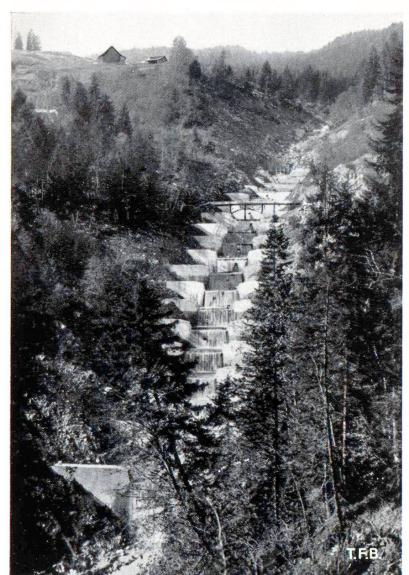
Fig. 6 Escalier de barrages en béton à déversoirs revêtus de pierres naturelles. Mettenlaui à Giswil, Obwald. Vue prise en 1934. Aujourd'hui les berges du torrent sont entièrement recouvertes de buissons et de jeunes arbres.
