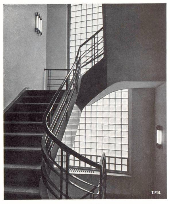
Fig. 5 Paroi de cage d'escalier en béton translucide
