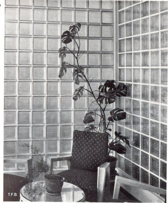
Fig. 6 Cloisons intérieures en béton translucide
