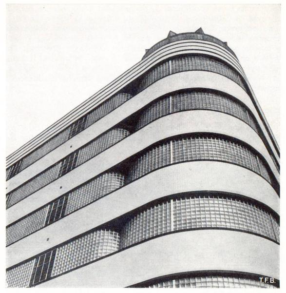
Fig. 4 Façade en béton translucide
