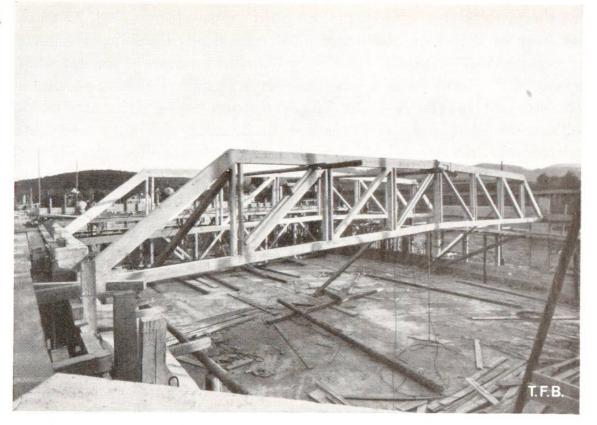
Fig. 6 Fermes médianes le 3ème jour de travail. A l'arrière - plan la plateforme de travail pour les fermes suivantes
