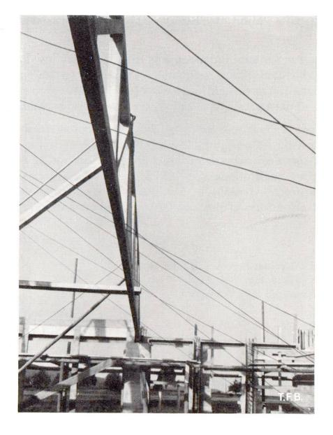
Fig. 5 Vue d'une ferme après la mise en place. La plateforme de travail a été déplacée
