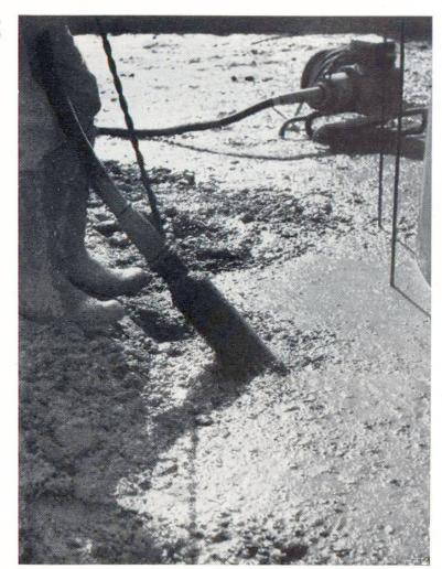
Fig. 5 Barrage de Rossens vibration du béton avec un vibrateur à aiguille. (Communiqué par l'Enfreprise du Barrage de Rossens, l'Entreprise No. 16/1947)
