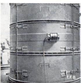
Fig. 7 Vibration extérieure, Vibrateur électrique en métal léger à gauche: fixé au coffrage d'un poteau en béton à droite: utilisé pour serrer le béton d'une paroi de tuyau
