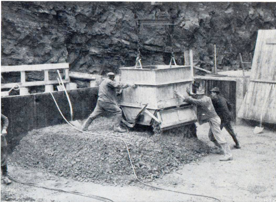
Fig. 4 Barrage de Rossens: mise en place du béton. (communiqué par l'Entreprise du barrage de Rossens, l'Entreprise No. 16/1947)
