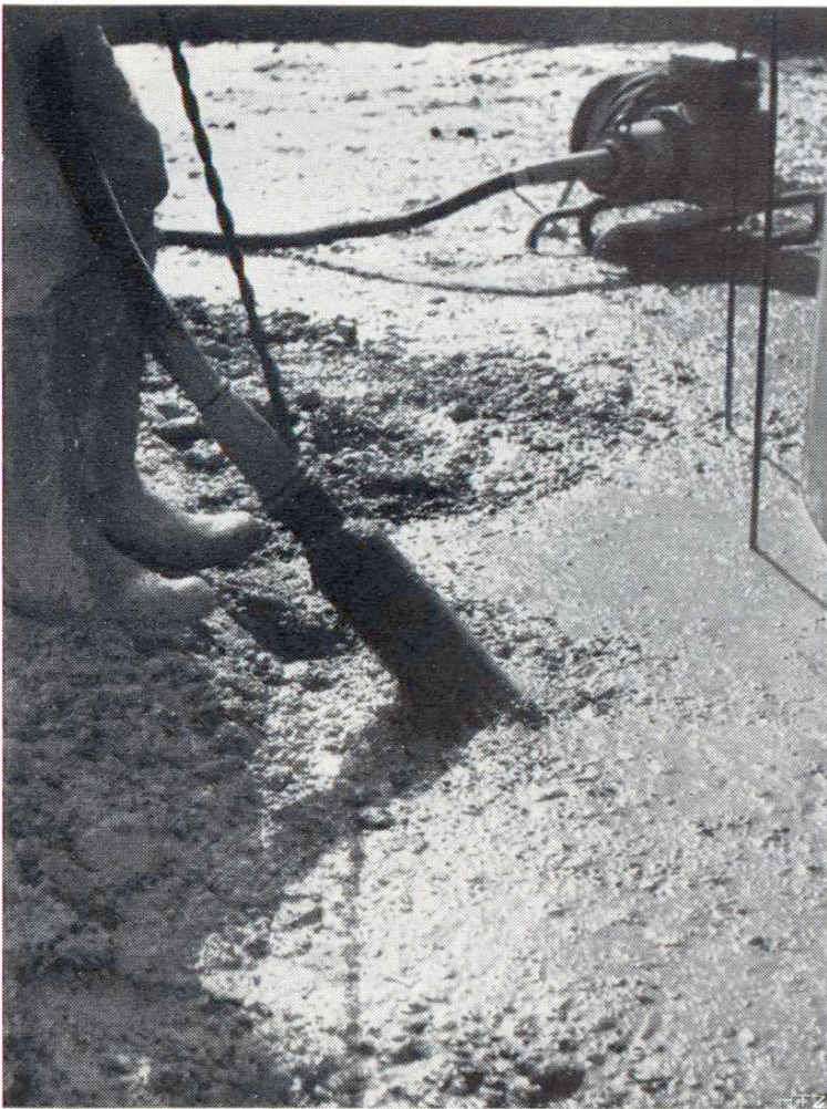
Fig. 5 Barrage de Rossens vibration du béton avec un vibreur à aiguille. (Communiqué par l'Entreprise du Barrage de Rossens, l'Entreprise No. 16/1947)
