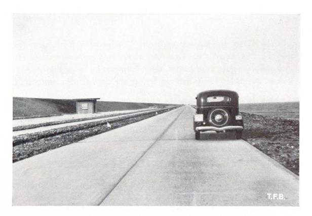
Fig. 6 La digue de 30 km de longueur du Zuidersee: Autoroute pure: La piste cyclable (à gauche) est séparée de l'autoroute par un fossé de 1 m de profondeur
