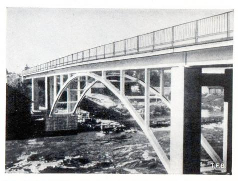
Fig. 4 Pont de Koskenniska sur la rivière Kymi, Finlande. Arc brisé raidi par le tablier. Portée 40 m (voir bibl.)
