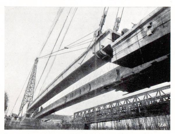
Fig. 7 Pont-route de Luzancy sur la Marne (France), inauguré en 1946. Pont-poutre de 55 m de portée. Hauteur de construction prescrite 1 m 30. Montage des poutres tubulaires précontraintes. Chaque poutre se compose de 22 éléments préfabriqués solidarisés au moyen d'armatures tendues (voir bibl.)
