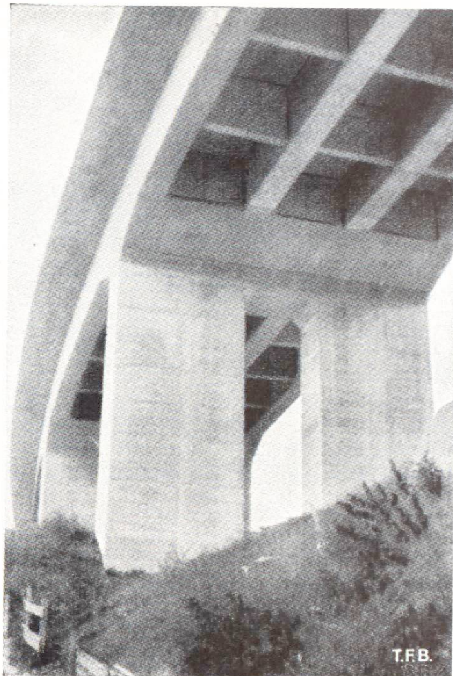
5 Fig. 5 Viaduc de la nouvelle ligne de Lorraine à 4 voies des CFF à Berne, construit en 1938/39. Pont en cadre à pilier résistant à la torsion et treillis de poutres constitué par une poutre maîtresse par voie et des entretoises (voir bibli.)
