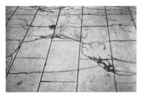
Fig. 3 Destruction d'un trottoir en béton sous l'action combinée du retrait et du gel
