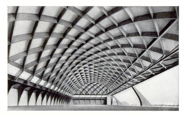
Fig. 5 Hangar en béton armé pour avions. (102×40) construit par Pier Luigi Nervi
