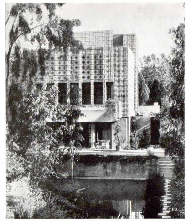
Fig. 1 Maison d'habitation en éléments de béton à Pasadena (Californie), construite en 1921 par l'architecte Frank Lloyd Wright
