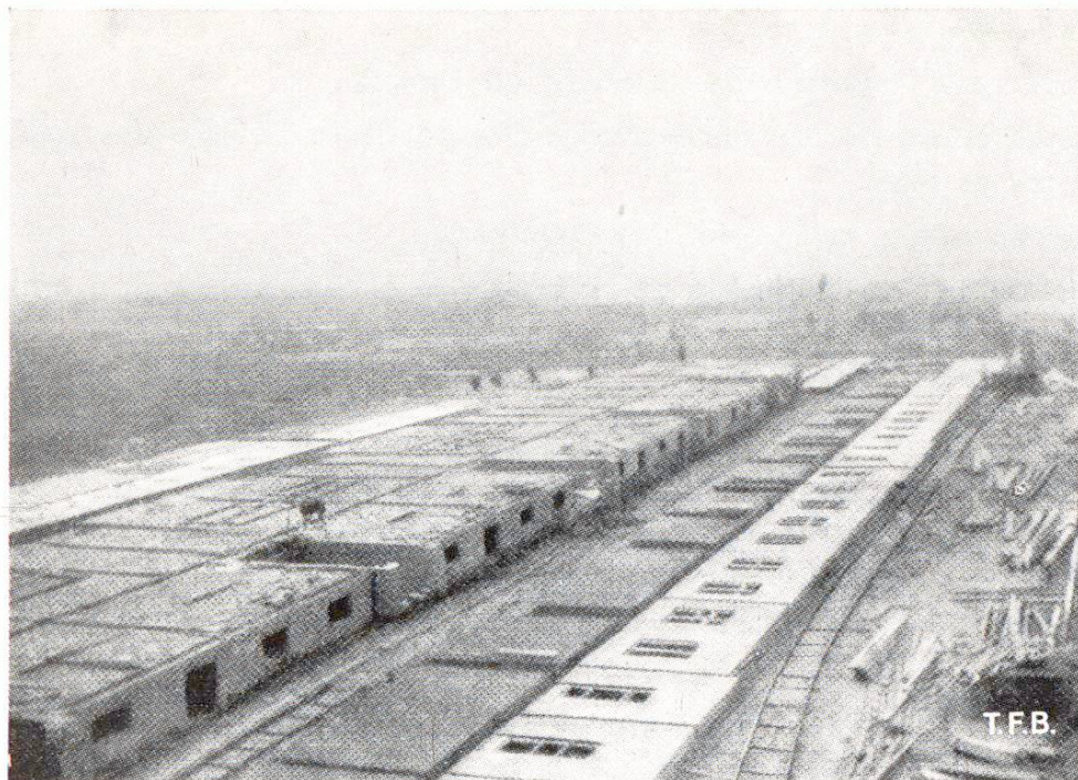
Fig. 2 Construction de parois entières de maisons
