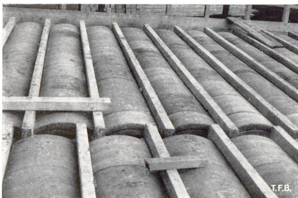
Fig. 3 Planchers composés de poutres en béton précontraint fabriquées d'avance et de hourdis en béton
