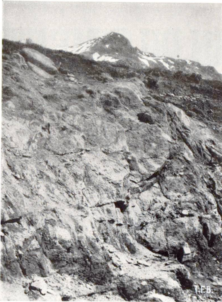
Fig. 1 En haute montagne, les roches cristallines (gneiss) ne montrent que dans des cas relativement rares une désagrégation vraiment profonde due aux influences atmosphériques. Massif du Gothard.
