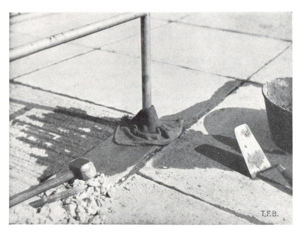
Fig. 5 Les petits ravaux de cimentage et de réparation exigent que l'on maintienne l'emplacement de travail humide. Un arrosage préalable abondant et une protection ultérieure au moyen de toiles de jute mouillées (sacs, etc.) donnent les meilleurs résultats
