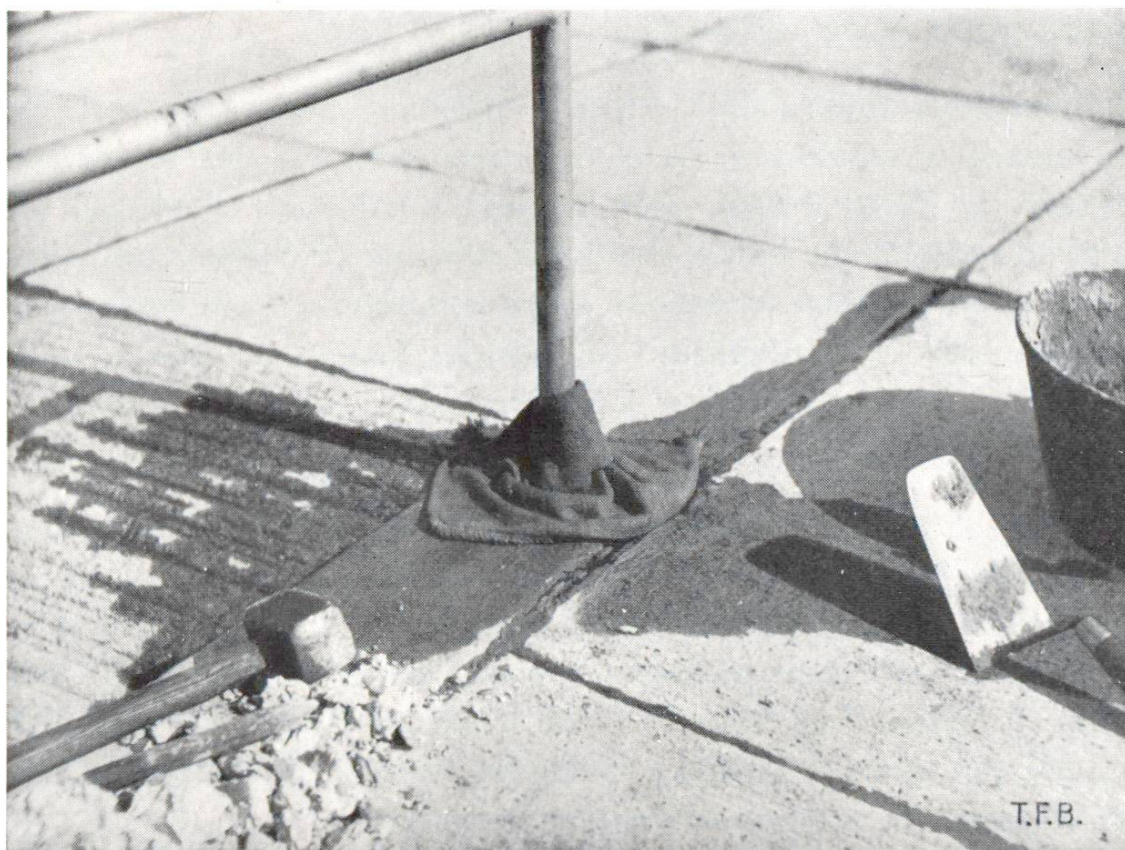
Fig. 5 Les petits ravaux de cimentage et de réparation exigent que l'on maintienne l'emplacement de travail humide. Un arrosage préalable abondant et une protection ultérieure au moyen de toiles de jute mouillées (sacs, etc.) donnent les meilleurs résultats
