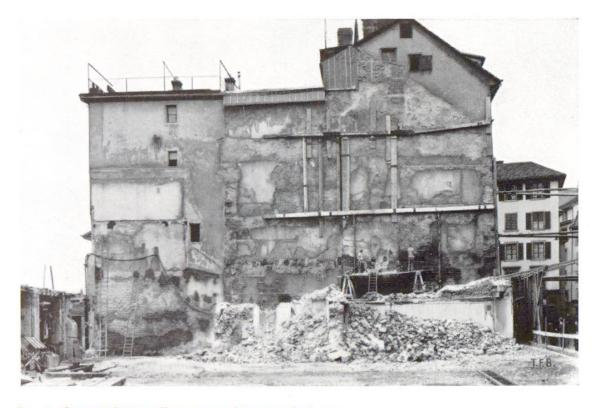
Fig. 8 Consolidation d'un mur mitoyen mis à nu
