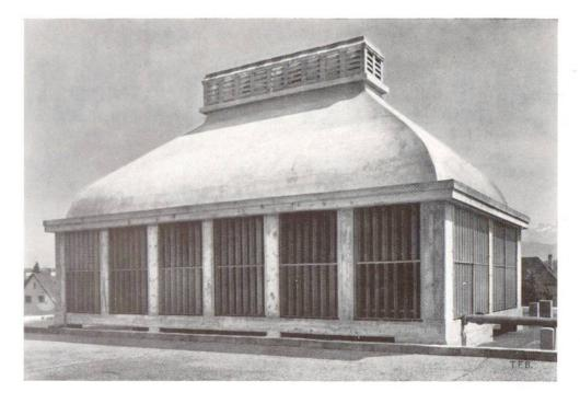
Fig. 1 Toiture voûtée d'un condenseur à ruissellement
