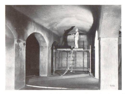
Fig. 7 Réparation du plafond en maçonnerie de pierres naturelles d'un réservoir d'eau Les voûtes du plafond d'un grand réservoir d'eau étaient en voie de décomposition. Pour écarter le danger, on enleva au ciseau la couche de maçonnerie détériorée et l'on projeta de bas en haut, en plusieurs couches, un revêtement de gunite de 3 cm d'épaisseur moyenne
