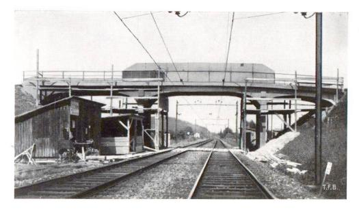
Fig. 11 Réparation d'un pont en béton armé
