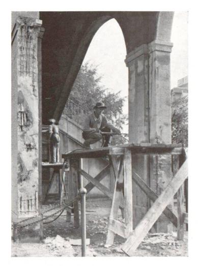
Fig. 6 Remise en état d'une passerelle en béton armé
