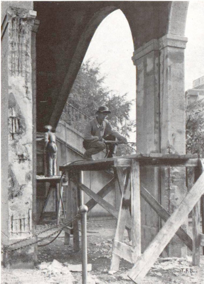
Fig. 6 Remise en état d'une passerelle en béton armé
