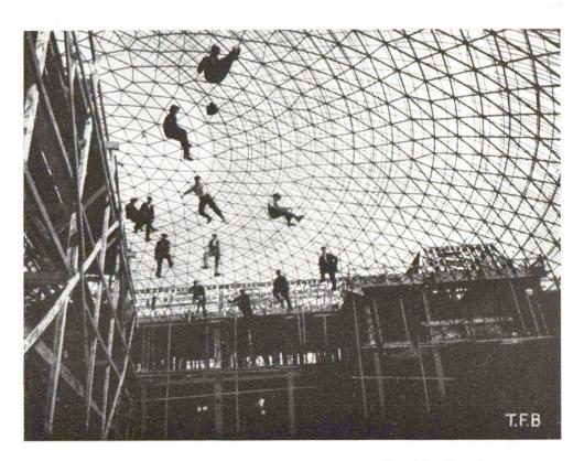
Fig. 4 Treillis métallique principal d'une coupole Zeiss-Dywidag.Les barreaux de 60 cm de longueur chacun sont reliés rigidement dans les nœuds.
