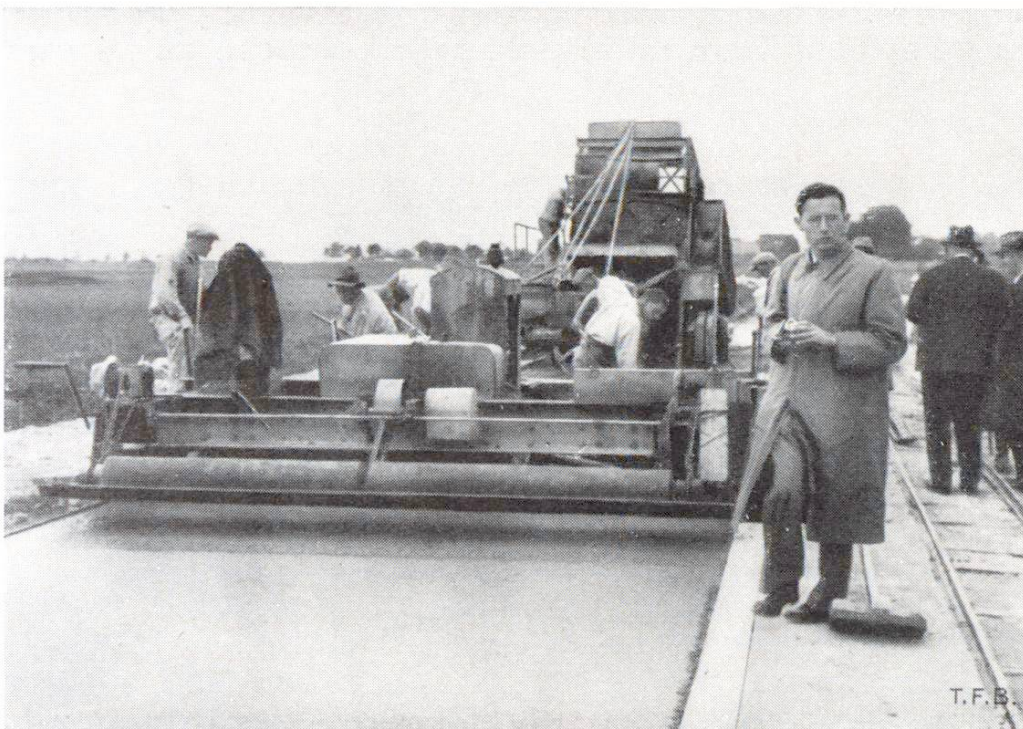
Fig. 7 Finisseuse de routes avec vibreur et malaxeur locomobile à roulement sur le chantier Soleure-Selzach
