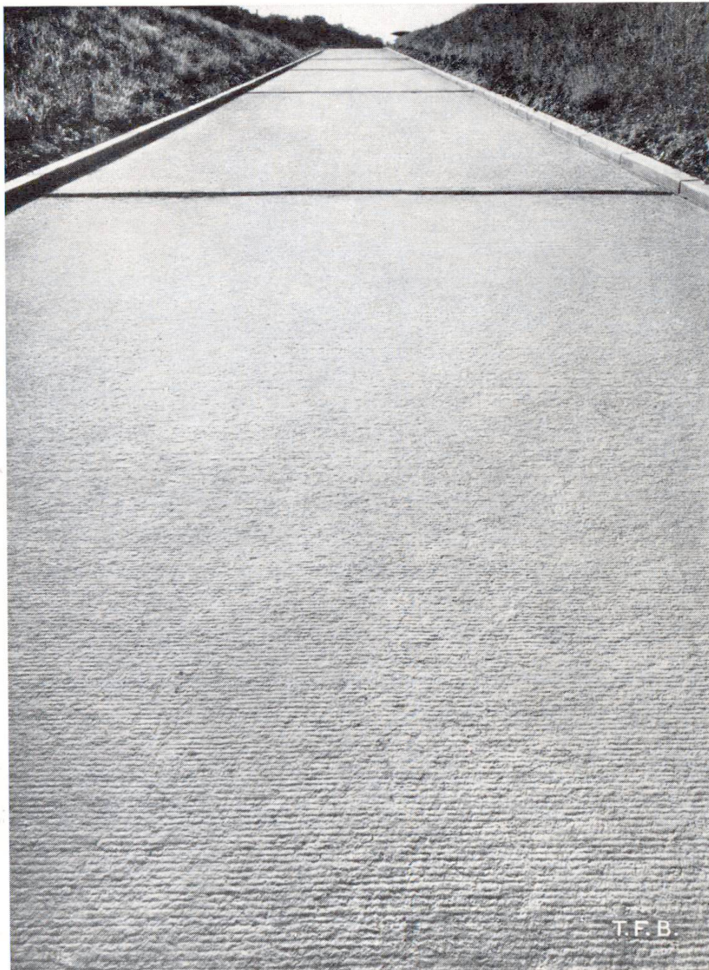
Fig. 3 Surface finement nervurée pour faibles pentes
