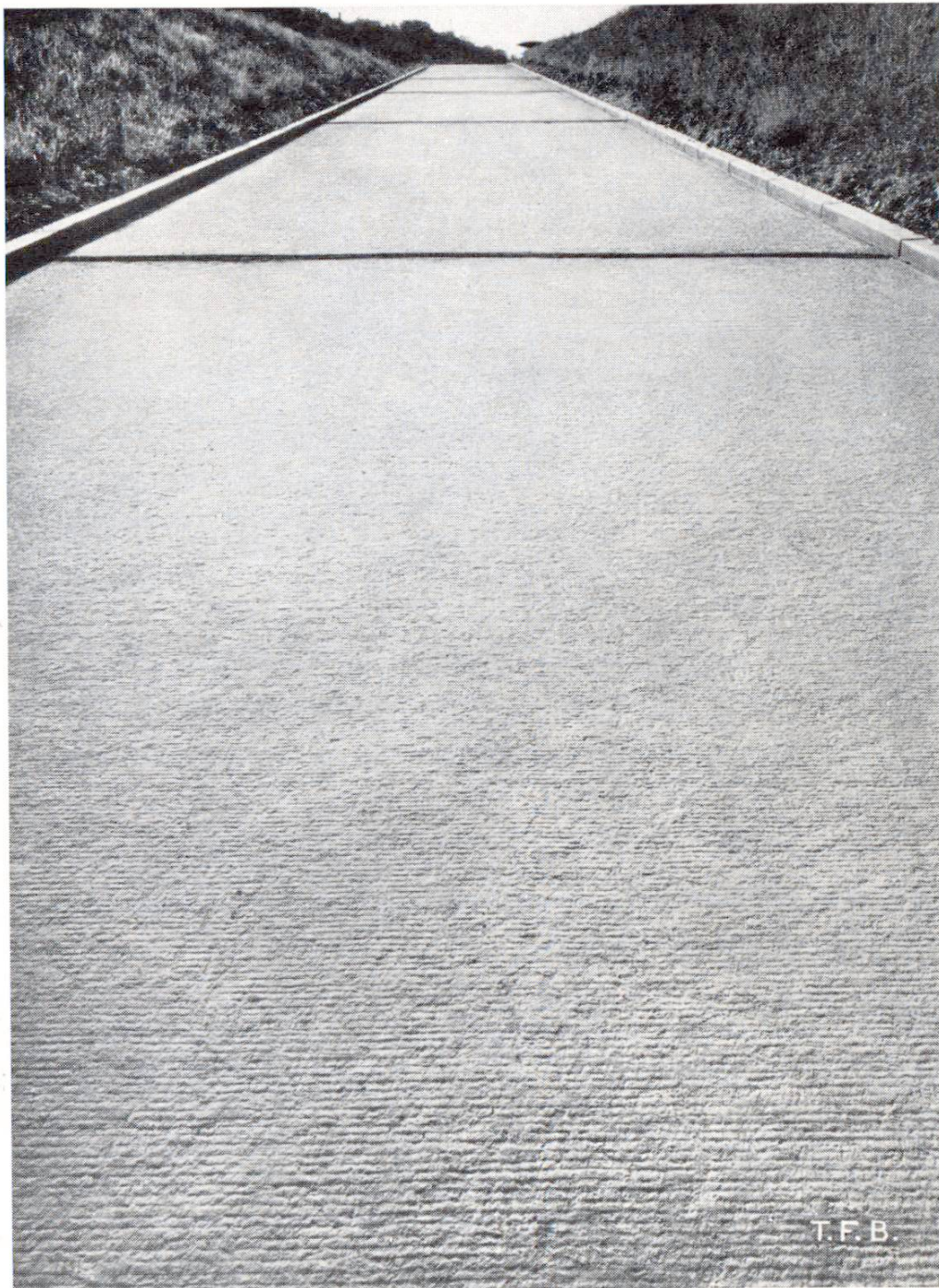
Fig. 3 Surface finement nervurée pour faibles pentes
