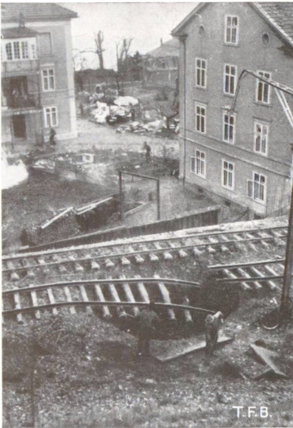
Fig. 1 Coup direct dans une voie de chemin de fer
