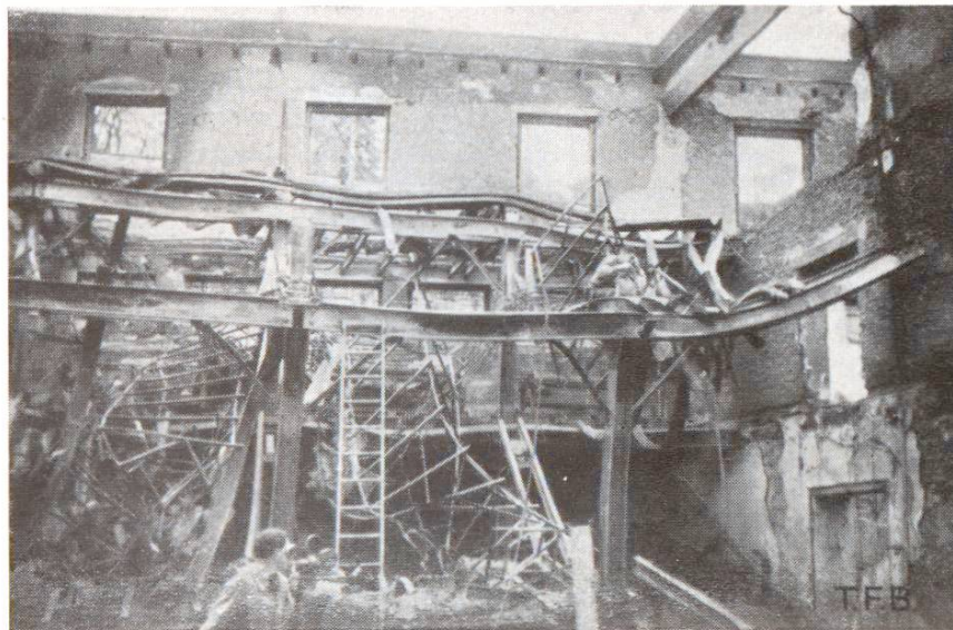
Fig. 13 Ossature métallique après la catastrophe
