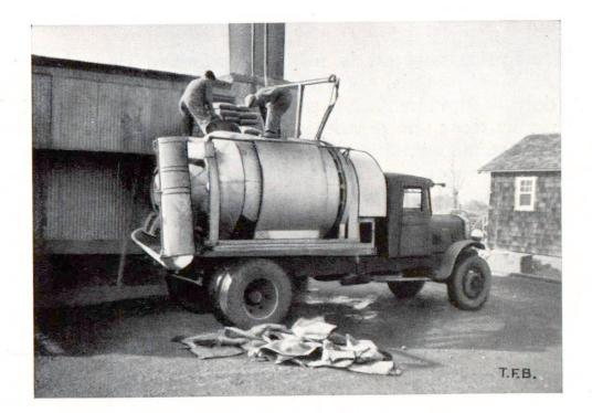
Fig. 6 Camion-malaxeur de 3m³. Le ciment est ajouté après l'introduction du sable et du gravier, puis l'eau est versée dans le malaxeur obturé. Celui-ci est actionné peu avant d'atteindre le chantier
