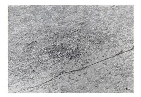
Fig. 6 Usure exagérée d'un revêtement en ciment par suite de l'emploi de mortier trop dilué pour la couche ribée
