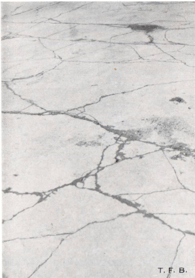
Fig. 2 Revêtement en ciment sur fondation insuffisante. Nombreuses fissures dans tous les sens
