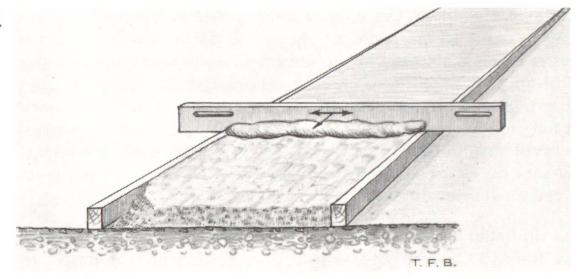
Fig. 3 Tirage de l'excès de mortier
