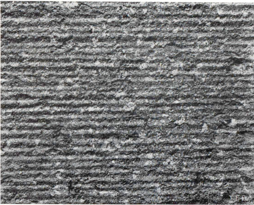
Fig. 5 Travail du béton à coups de laie
