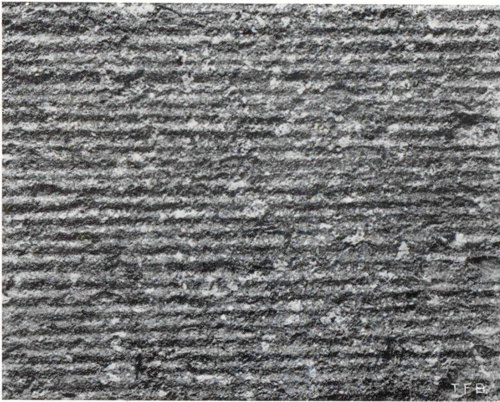
Fig. 5 Travail du béton à coups de laie
