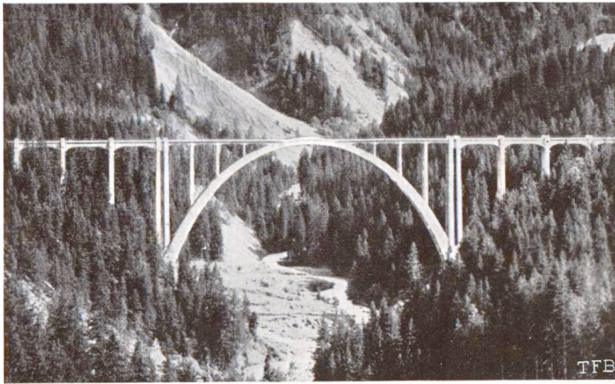
Fig. 5 Viaduc de Langwies (1914)
