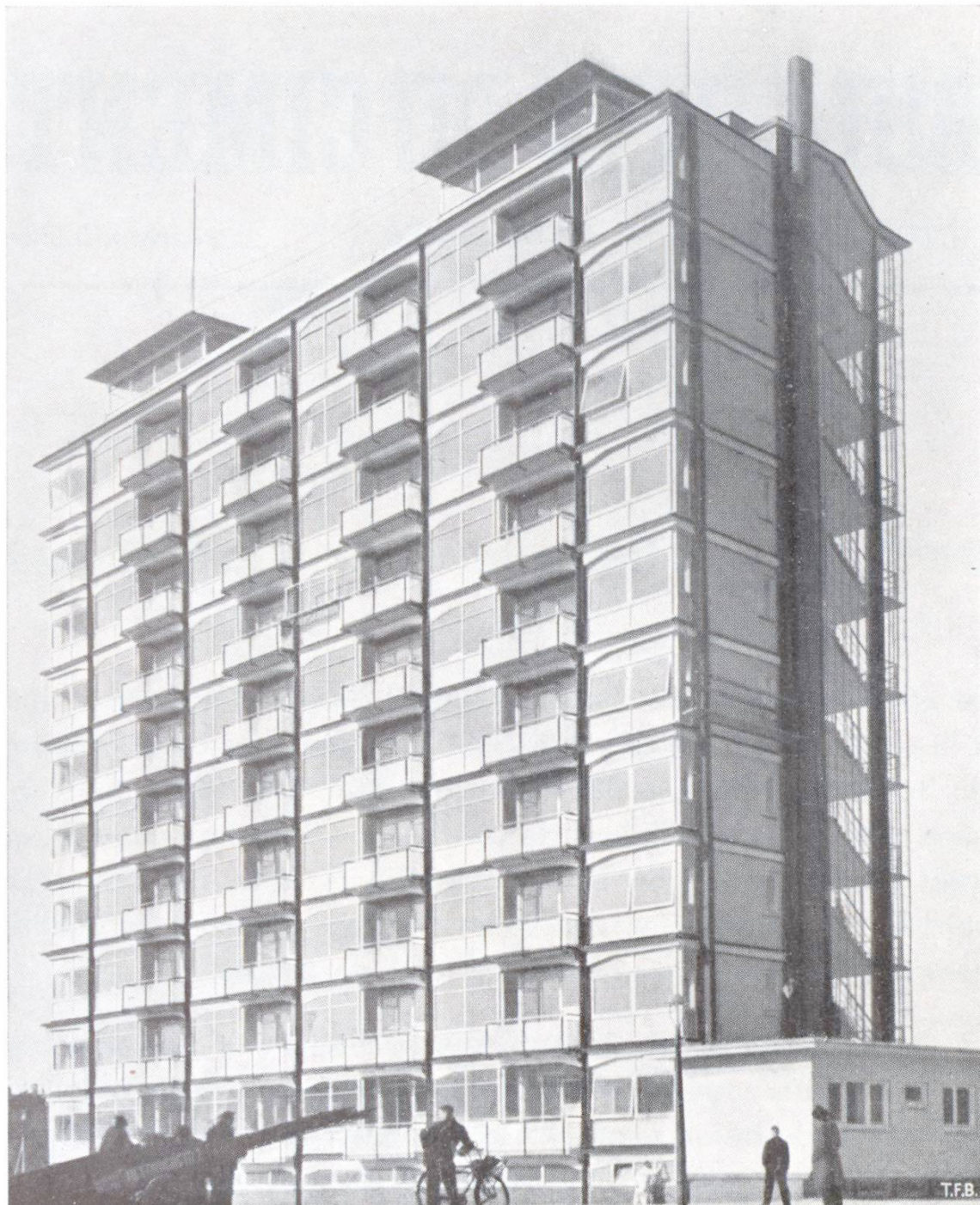
Gratte-ciel à Rotterdam. Architectes W. van Tijen et H. A. Maaskant. L'ossature en béton armé donna, au point de vue technique et surtout acoustique, de meilleurs résultats qu'une ossature métallique éprouvée dans un ouvrage analogue érigé 4 années auparavant
