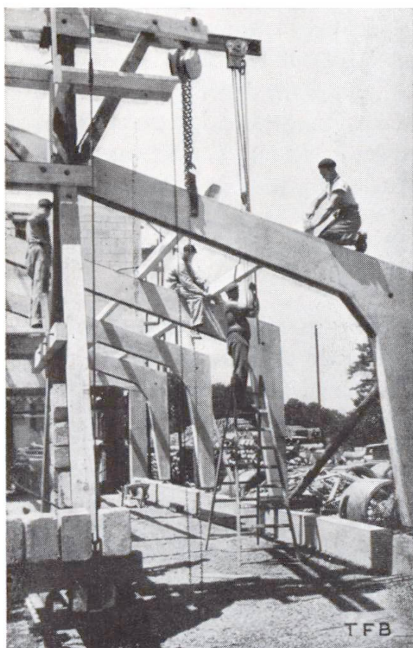
Fig. 4 Montage des pannes
