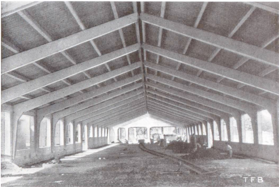
Fig. 3 Toit vu de dessous après la pose de l'éternit ondulé
