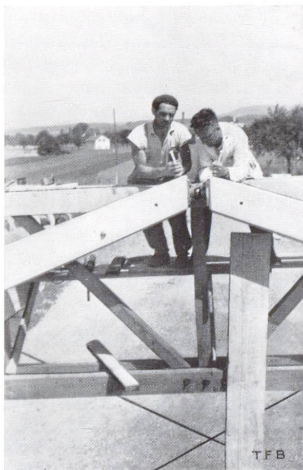
Fig. 5 Articulation de clef des fermes
