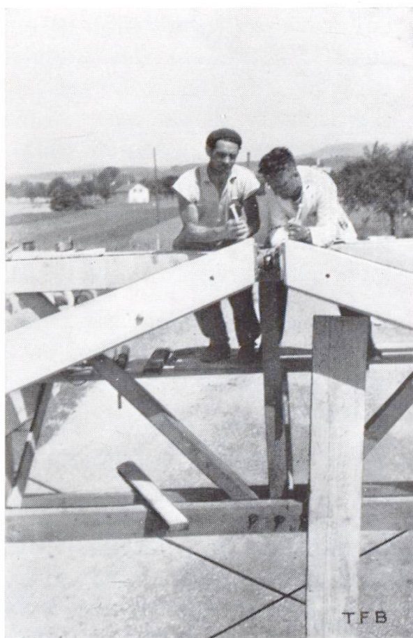
Fig. 5 Articulation de clef des fermes
