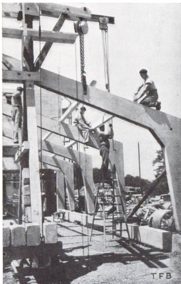
Fig. 4 Montage des pannes
