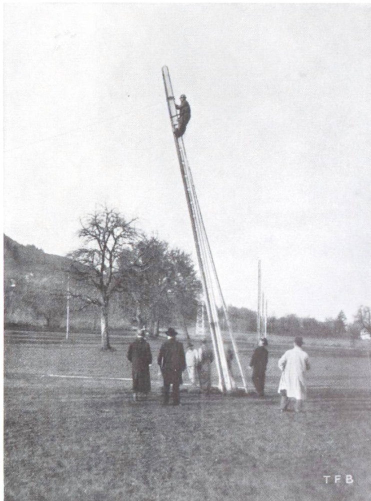
Fig. 2 Poteau de la conduite de l'Albula à section en H pendant l'essai de rup- ture après 32 ans de ser- vice.
